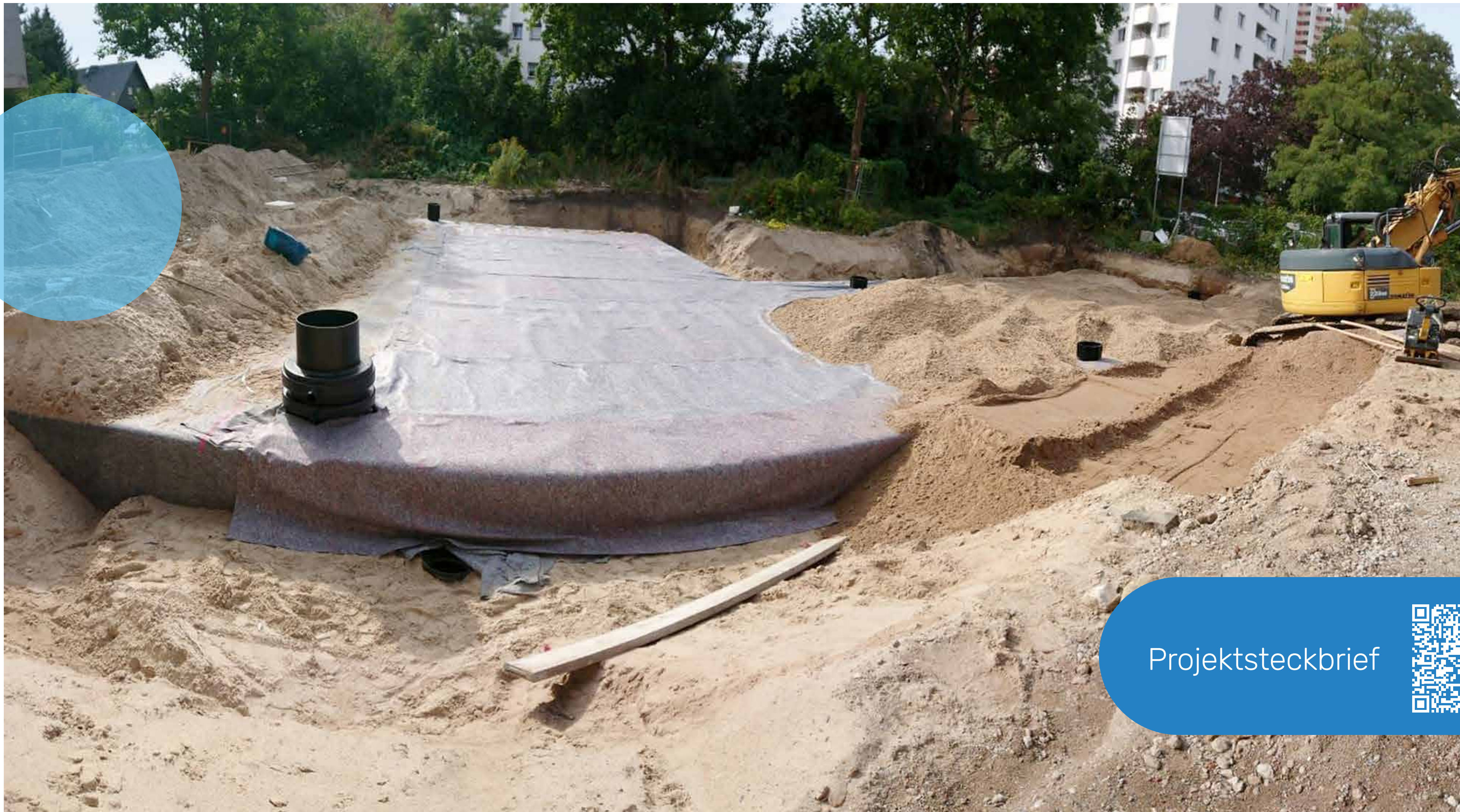
Einbau des gedichteten Rigolenfüllkörpers
