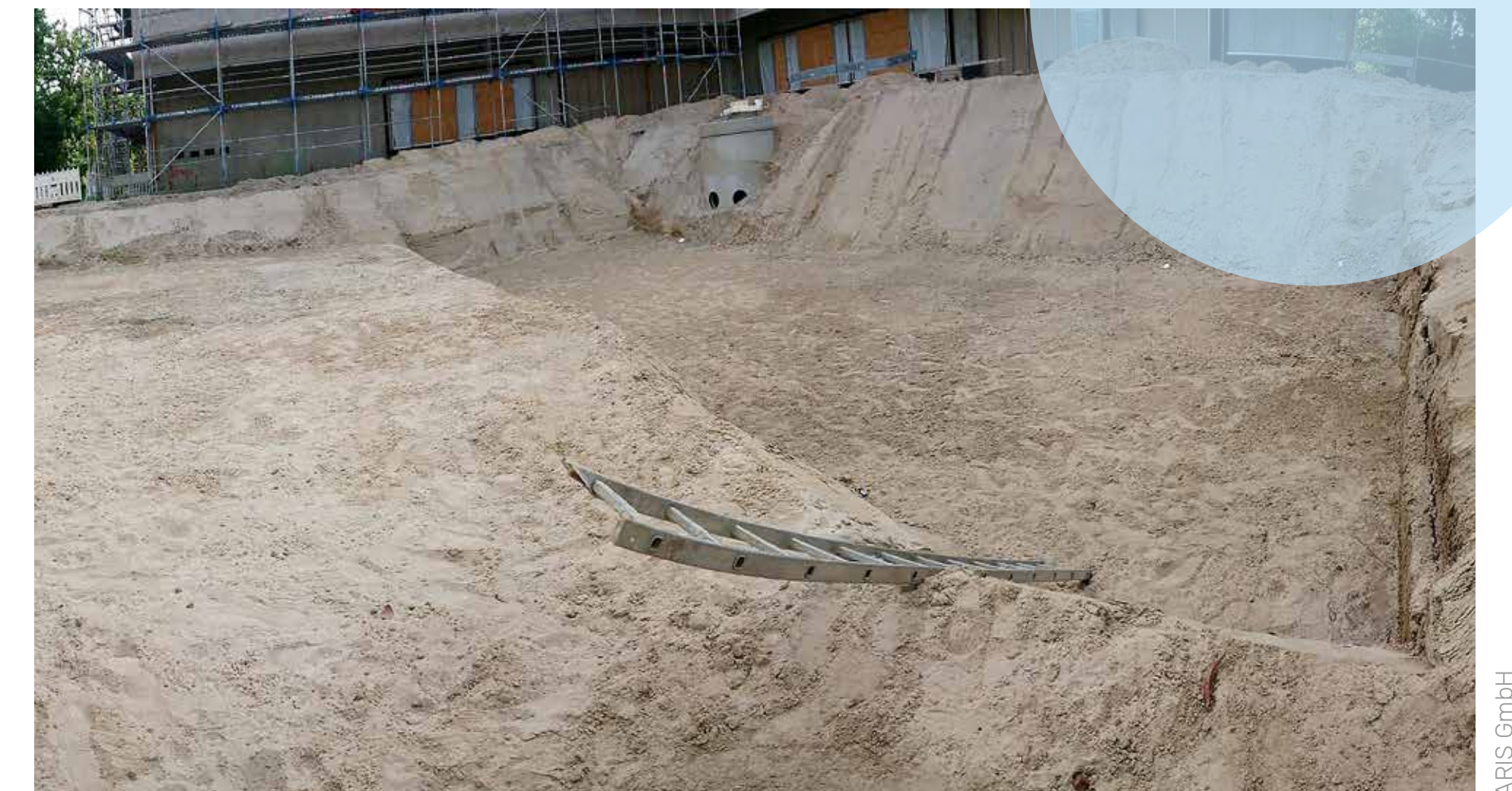
Stufenform der Baugrube
