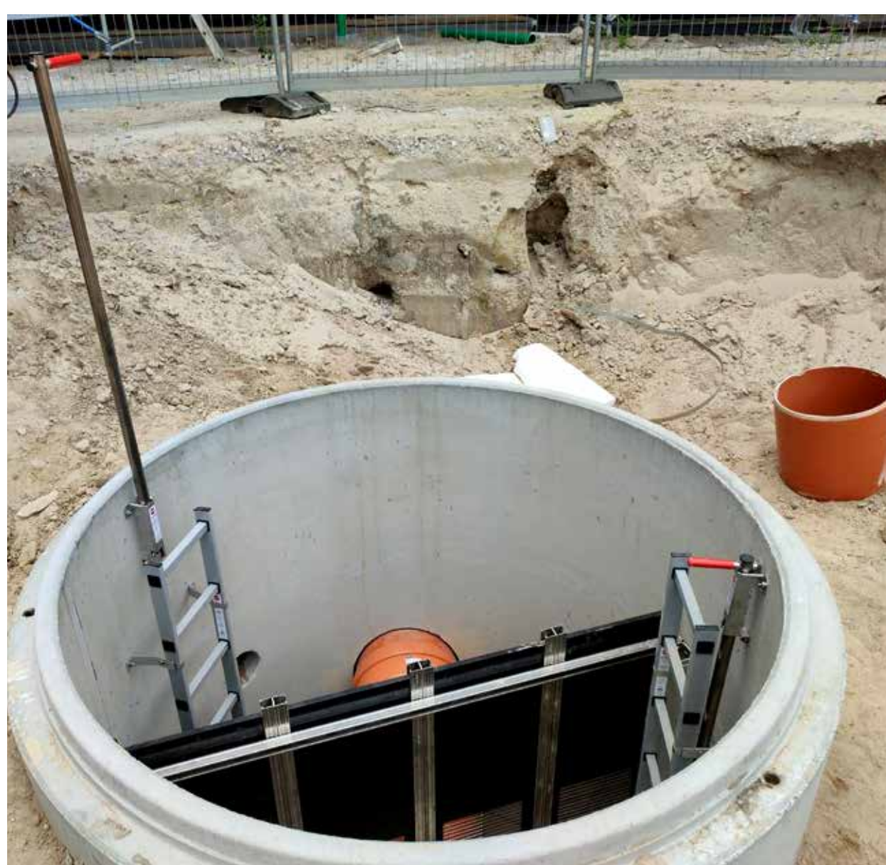
Einbau Filterwand
