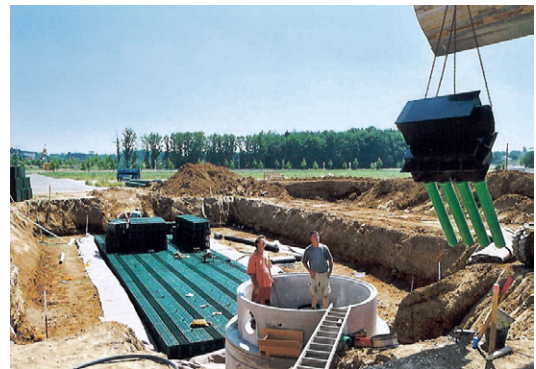
ARIS-LUPO Filter für Regenrückhaltungsanlage mit RIGO-collect
