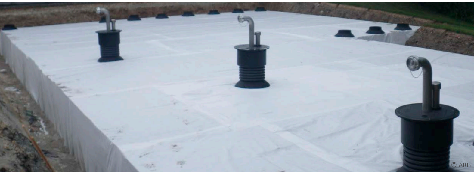
Löschwasserbevorratung nach DIN 14230 (2012), Evoqua Günzburg
